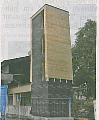
Der Schlauchturm für das neue Feuerwehrhaus ist fertig. FOTO: HW
